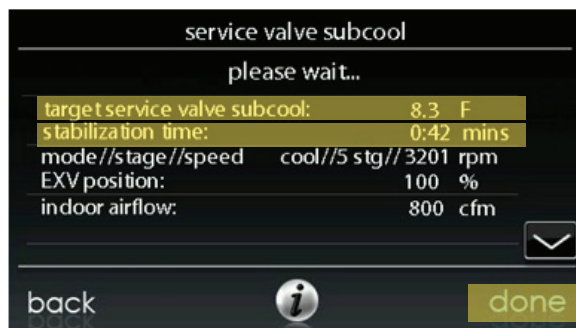
Figure 18 – Temps de stabilisation A14575
