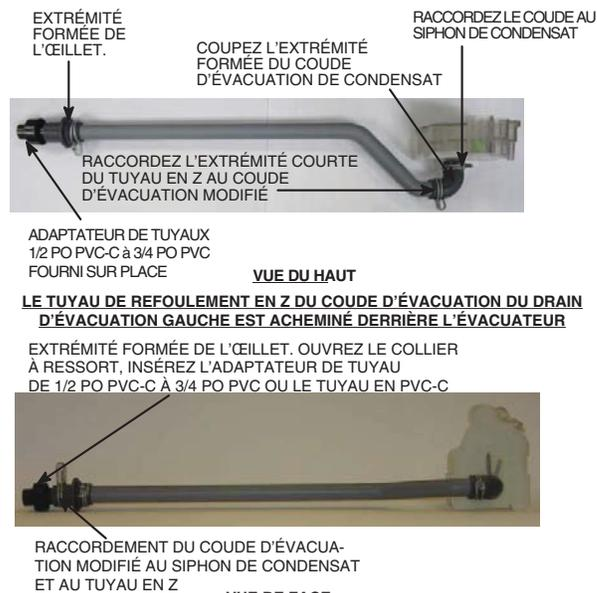
**ORIENTATION DU TUYAU DE DRAIN D'ÉVACUATION GAUCHE POUR L'ÉVACUATION DU CONDENSAT**
