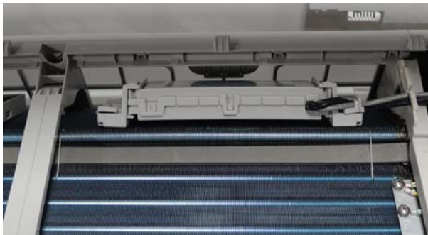
Figure 31 – Installation de la carte multifonction
